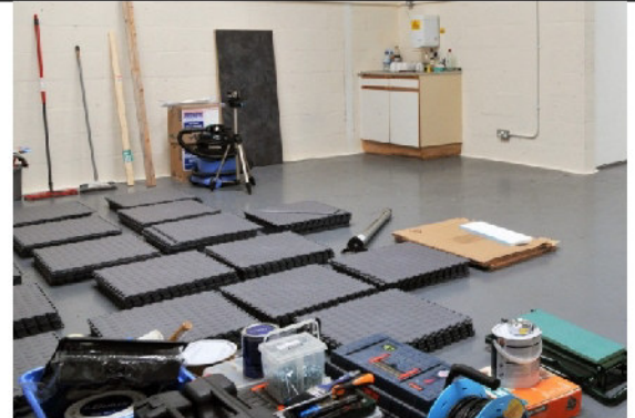
Bild Nr. 1 teilen Sie bitte die Palette auf um den Akklimatisationsprozess zu beschleunigen
