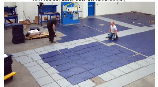
Bild Nr. 4 teilen Sie bitte die Palette auf und verlegen Sie die Fliesen lose, bevor Sie mit dem Fixieren anfangen
