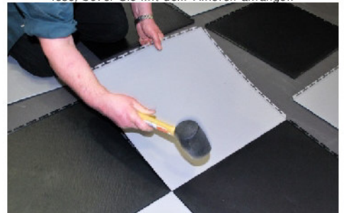
Bild Nr. 5 Beginnend von einer Ecke, mit wenig Druck zwei Fliesen mit dem Gummihammer klopfend, kreisförmig verbinden
